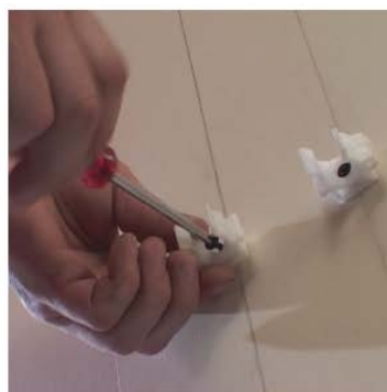
Устанавливаются подвижные опоры
