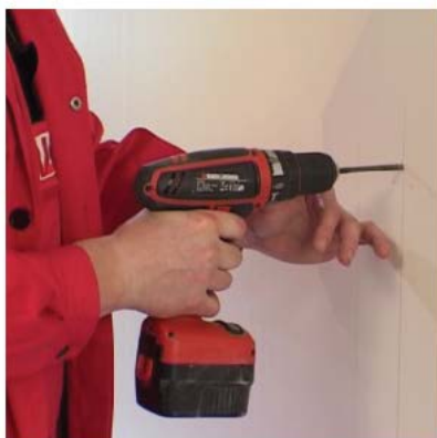
Высверливаются гнезда для крепления опор и водорозеток
