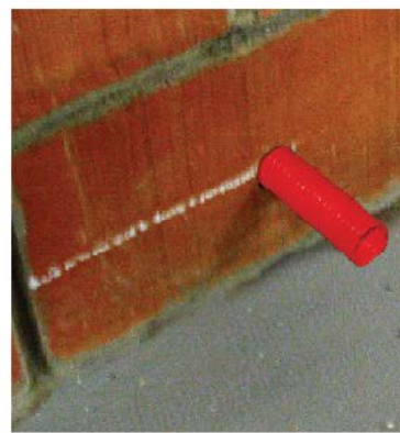
Устанавливаются гильзы из гофрированной трубы в отверстия стен и перегородок так, чтобы гильза выступала не менее чем на 50 мм за грань конструкции.
